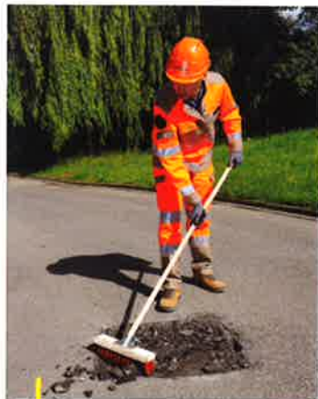
1. Čišćenje udarne rupe od fizičkog oštećenja
