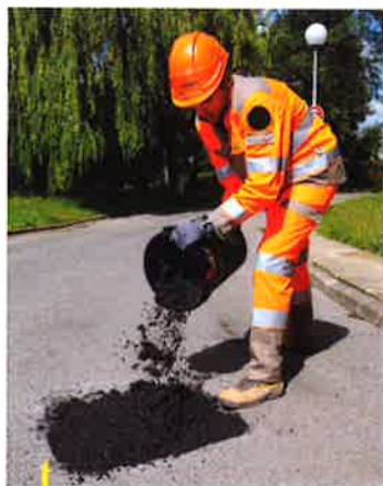
2. Prije ugradnje premazivanje podloge odgovarajućom emulzijom
