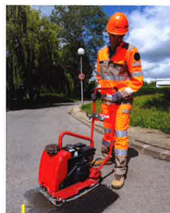
4. Zbijanje vibro pločom ili adekvatnim valjkom
