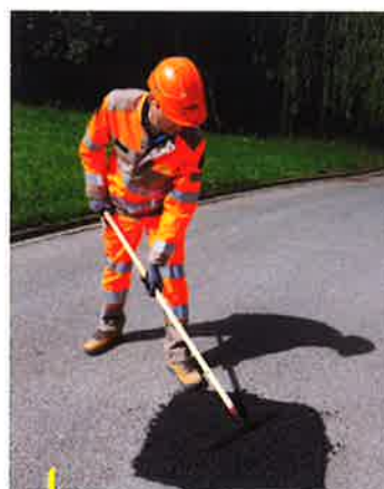
3. Razastiranje hladnog asfalta
