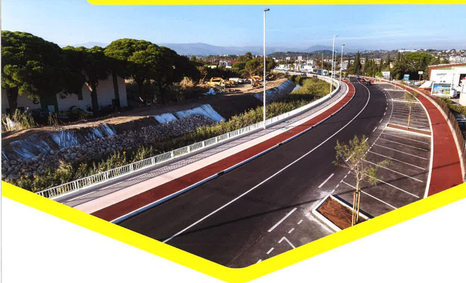
COLCLAIR® je naziv za assortiman asfalta u boji kod kojeg se umjesto klasičnog cestograđevnog bitumena može koristiti sintetičko vezivo pod nazivom Bituclair®. Sintetsko transparentno vezivo boje bagremovog meda ima ista fizičko mehanička svojstva kao i cestograđevni bitumen.
