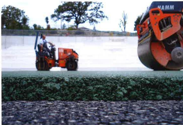
Asfalt u boji Colclair® može se izraditi od bilo koje vrste vrućih asfaltnih mješavina te je njegova ugradnja identična tehnologiji i strojevima klasičnoj ugradnji asfalta. Receptura se u doziranju veziva i frakcija kamenih materijala ne razlikuje od proizvodnje klasičnog asfalta (Tehničke specifikacije: HRN EN 13108-1, HRN EN 13108-2)
